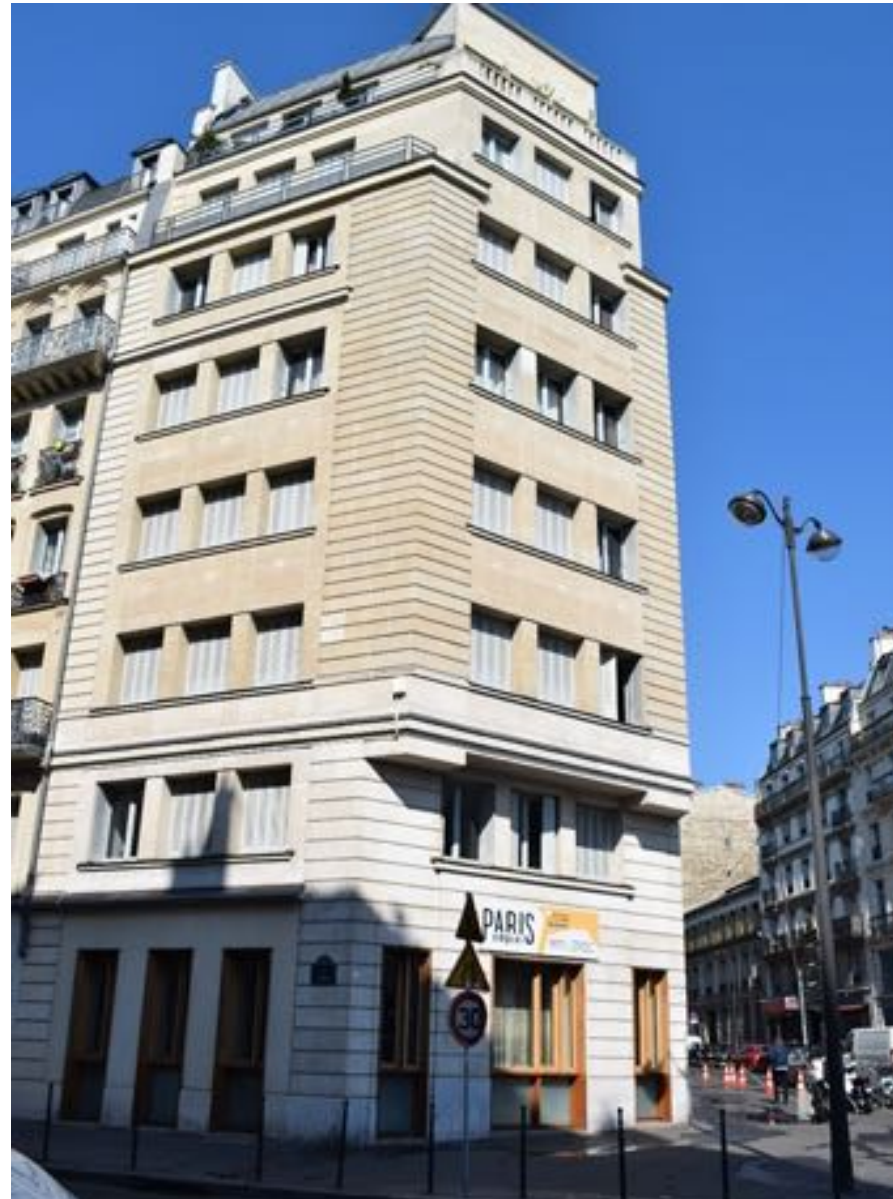
Sede della Confederazione oggi
